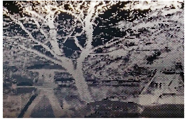
兼六園の写真データをパンチングし壁面パネルとして施工した事例
